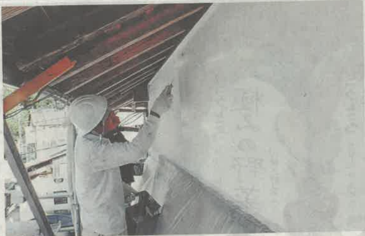
関西ペイントのしっくい塗料を塗った壁
